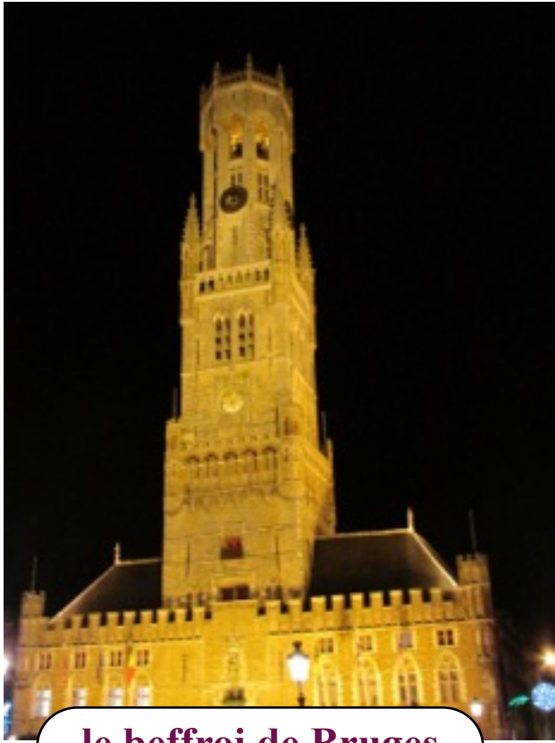
le beffroi de Bruges
